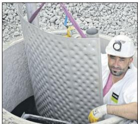
Eine Platte vom Wärmetauscher wird in den Abwassersammler eingebaut. Foto: Fischer
