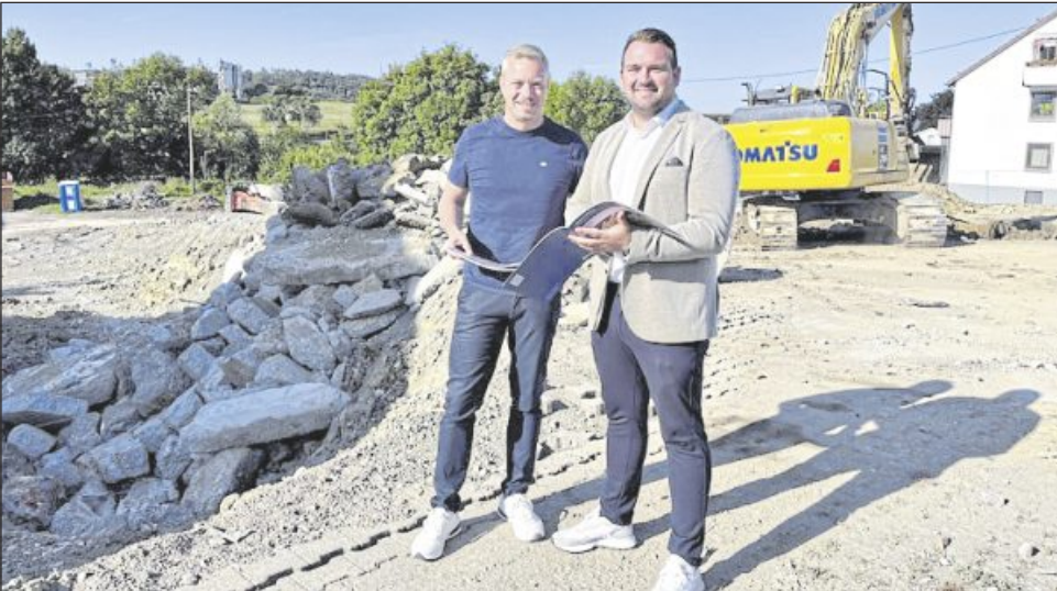
Kai Franke (Prokurist bei Projektbau Pfeleiderer, links) und Sven Andrä (Geschäftsführer) auf dem Gelände an der Schwaikheimer Straße. Foto: Tobias Klecker
